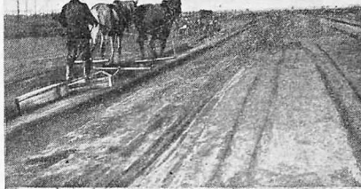
Рис. 4. Копание треугольных канав канавокопателем
